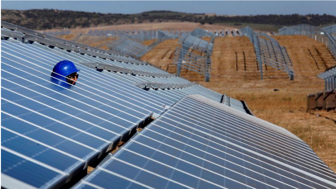
Construcción de una planta de paneles solares. EP
